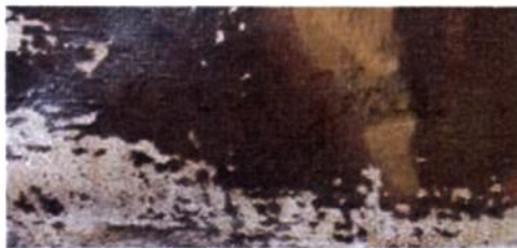
Az alapozó- és festék kipergés a szignatúra körül, részletfelvétel, átvételi állapot
